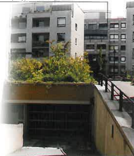
Εικόνα 2: Ταρτσόκηπος με το σύστημα Bacel
