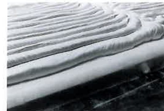
Εικόνα 5: Εφαρμογή του υποστρώματος Bacel στο χώρο ταρτσόκηπου
